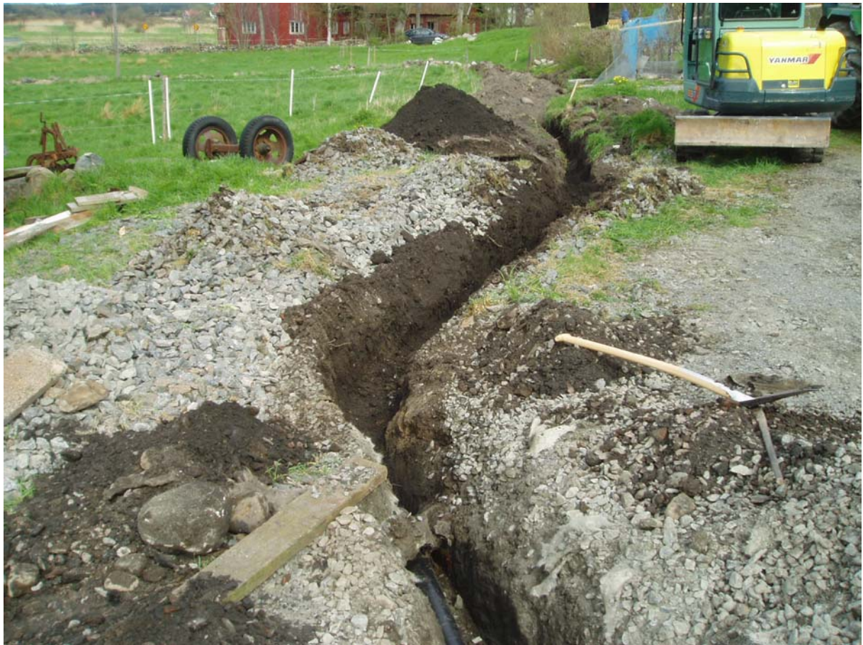
Bild 13. Schakt över 3:8 vid gavel lada
