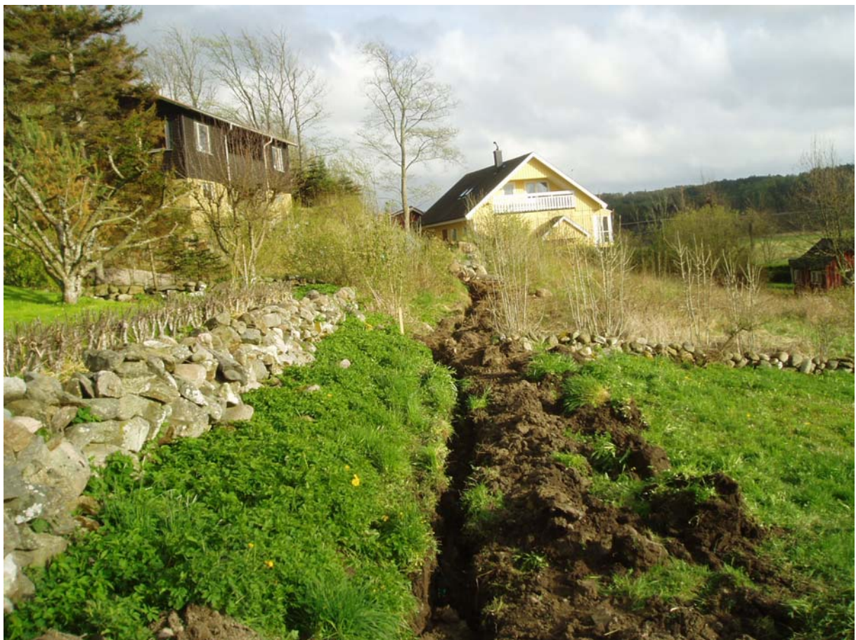
Bild 18. Parallelt med 3:8 boningshus nedanför stenmur schakt i åkermark.
