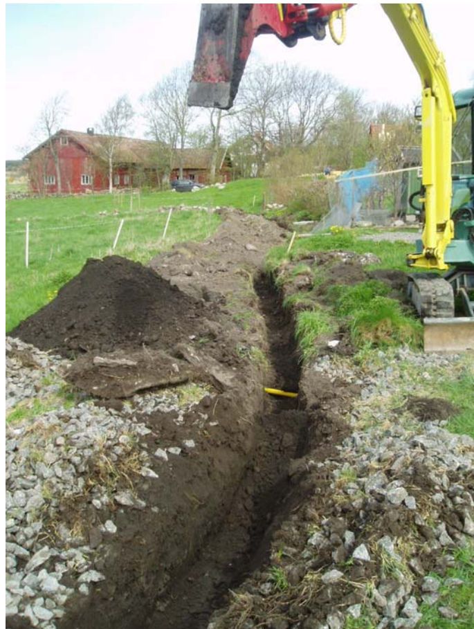
Bild 12. Schakt över 3:8 vid gavel lada
