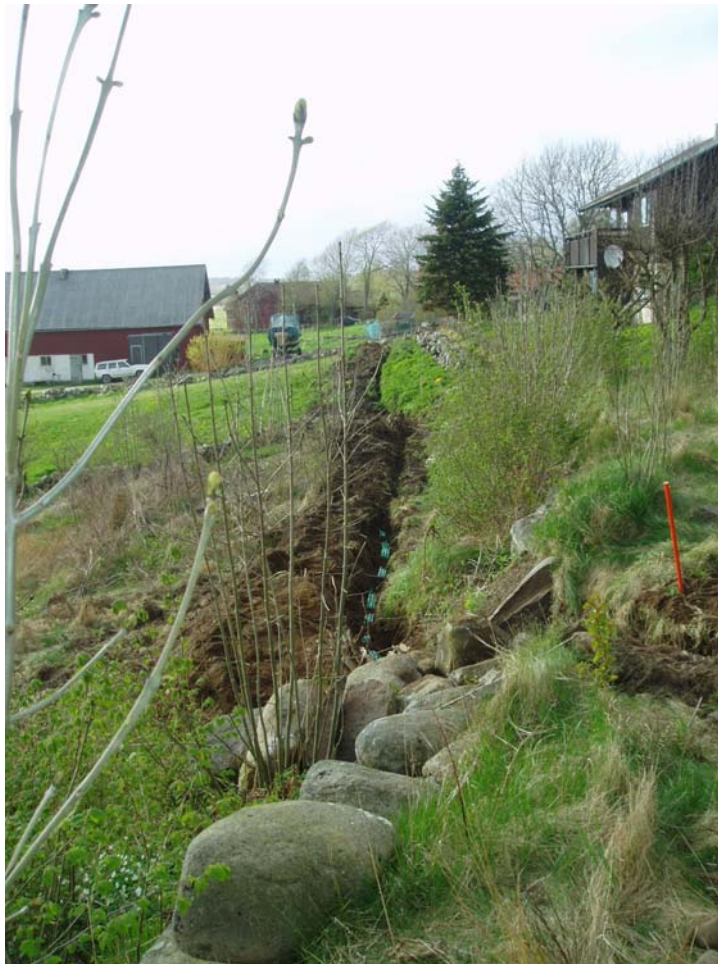
Bild 19. Parallelt med 3:8 boningshus nedanför stenmur schakt i åkermark mot 5:10.
