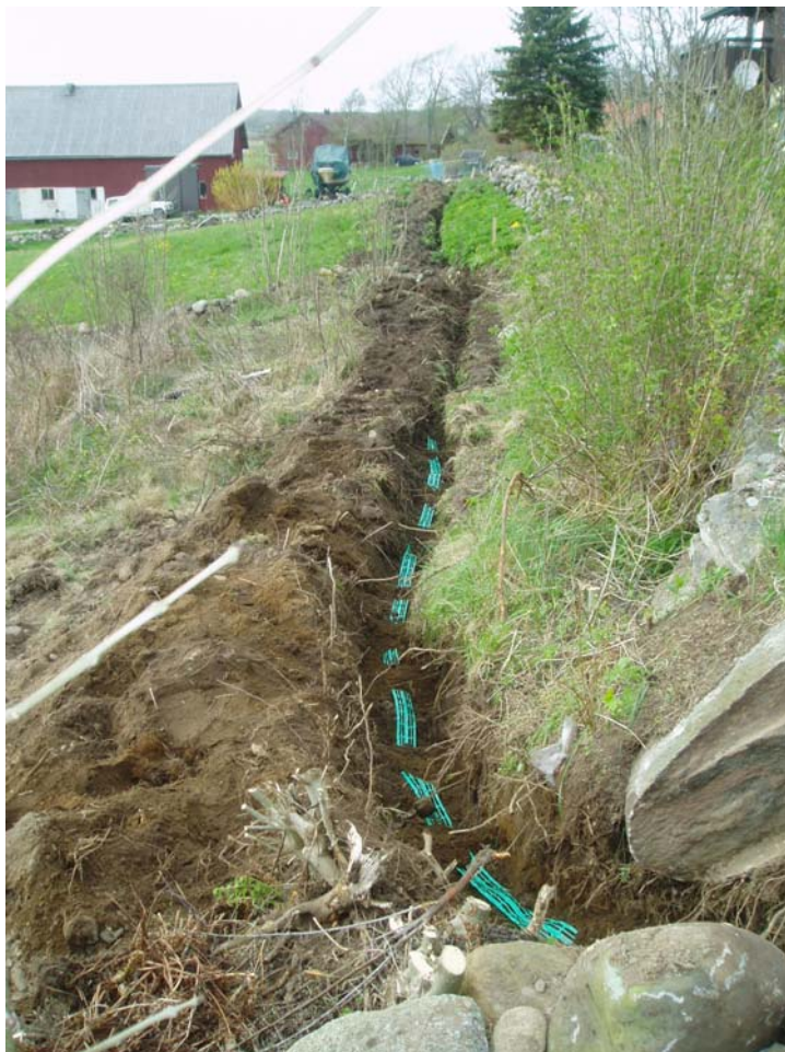
Bild 20. Från 3:8 nedanför stenmur schakt i åkermark Till 5:10 med skydds plast.
