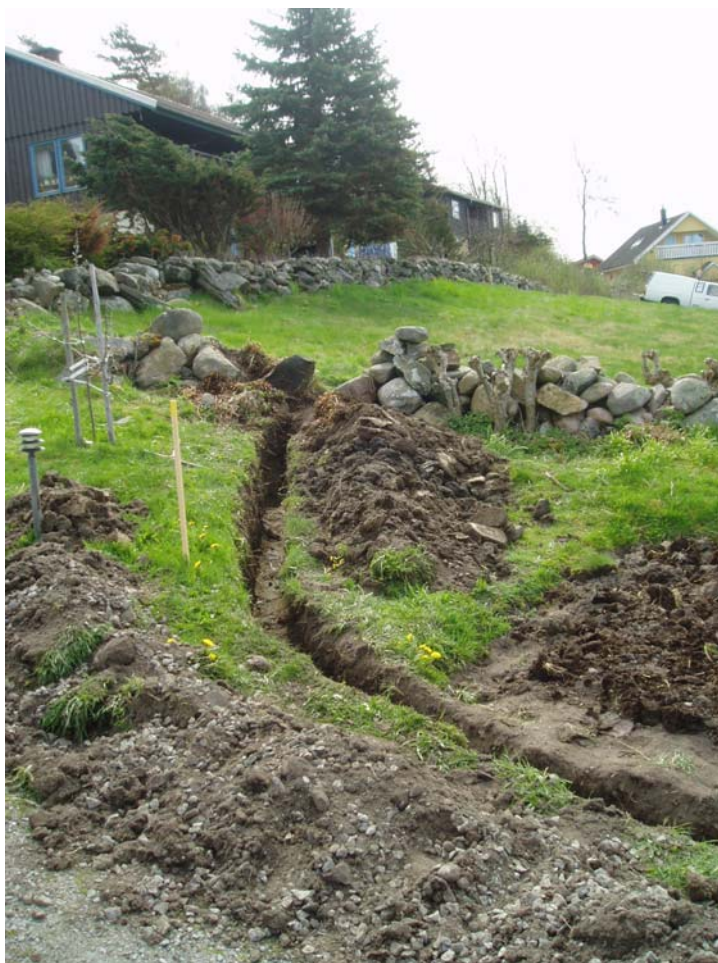
Bild 16. 3:8 över Elkablar ( handschakt genom stenmur)
