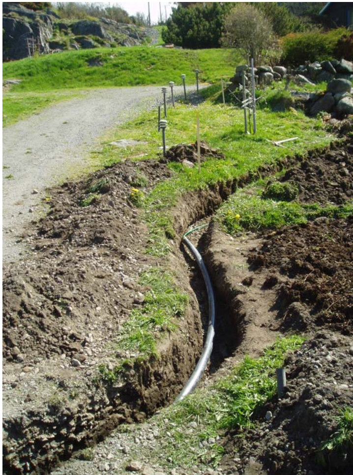
Bild 15. Schakt efter väg 3:8 samt över Elkablar ( handschakt till stenmur)
