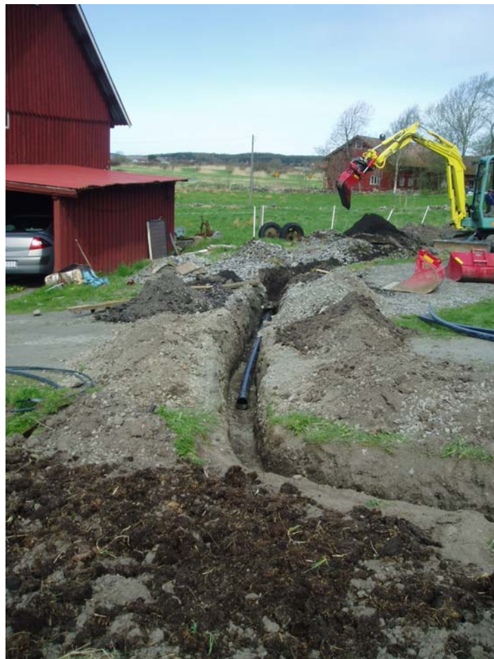
Bild 14. Schakt över 3:8 vid gavel lada + schakt över väg.
