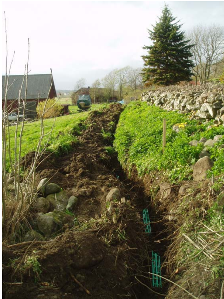
Bild 17. Parallelt med 3:8 boningshus nedanför stenmur schakt i åkermark.
